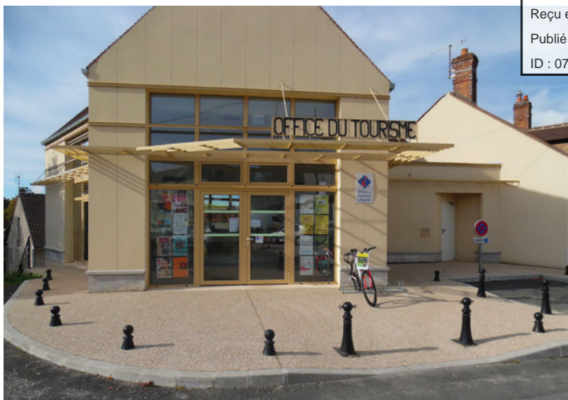
BIT de Souppes-sur-Loing
